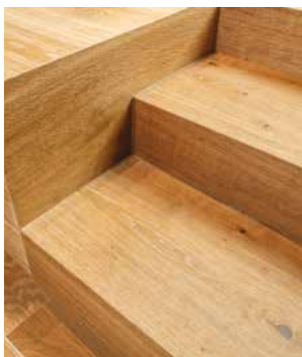
Trappa med slutna trappsteg
